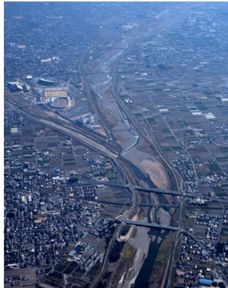
重信川下流部（石手川合流付近）
