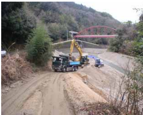
堆砂除去の状況（石手川ダム）
