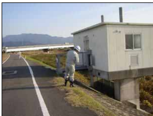
排水門点検状況
