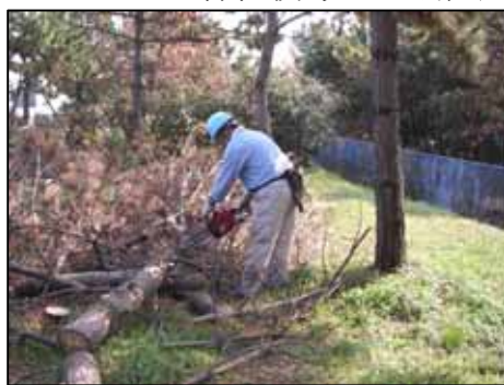
樹木伐開状況 (重信川 河口より0.1km 付近 松前町側)
