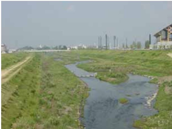
中央公園橋上流
