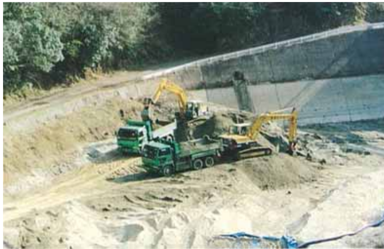
貯砂ダム内の堆砂除去状況
