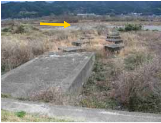
コンクリート透過水制（田窪第一水制） （重信川 河口より 15.5km 付近 東温市北側）
