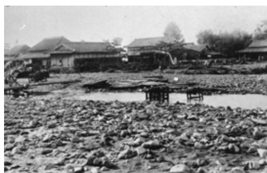
松山市提供 はん濫のつめ跡(松山市久谷地区)
