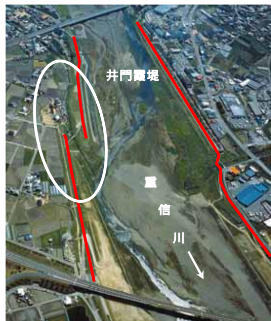
下流側上空から井門霞堤を望む
