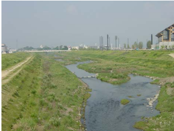
中央公園橋上流
