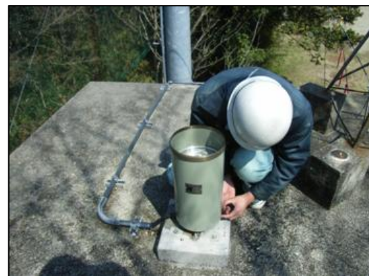
雨量観測施設点検状況
