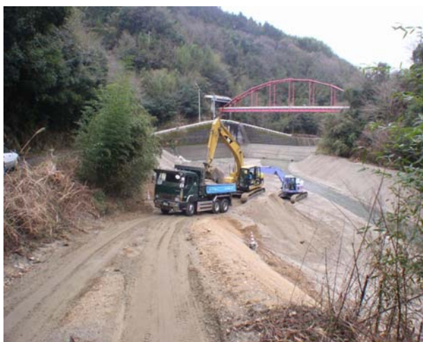
堆砂除去の状況（石手川ダム）
