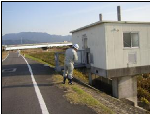
排水門点検状況
