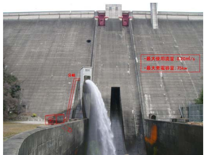
管理用水力発電施設のイメージ図
