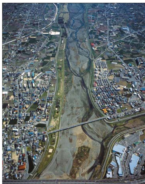
重信川中流部（重信橋付近）
