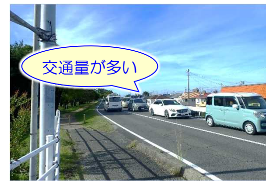
現状（和泉橋下流右岸の堤防天端道路）
