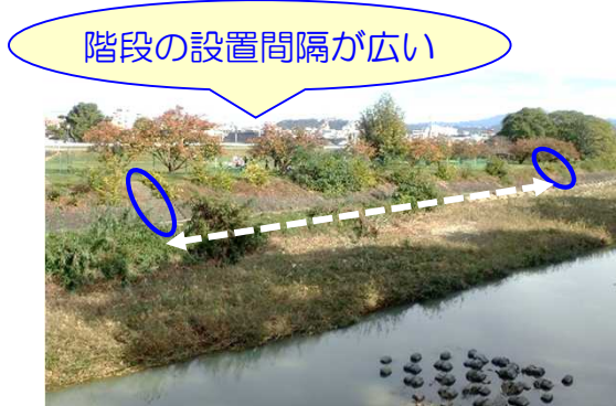
現状（泉永寺橋上流右岸）
