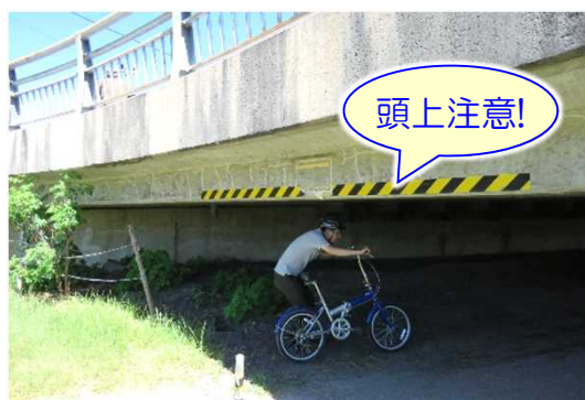
和泉橋現況アンダーパス
