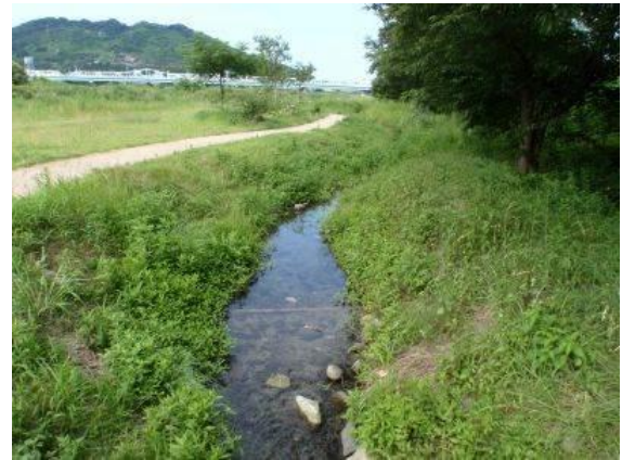
生物に配慮して施工した小川
