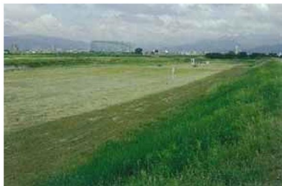
河川敷公園 (重信川 河口より 7.8km 付近砥部町側)
