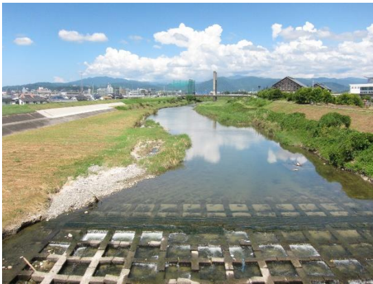
中央公園橋付近
