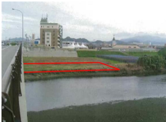
整備前の河口右岸の様子
