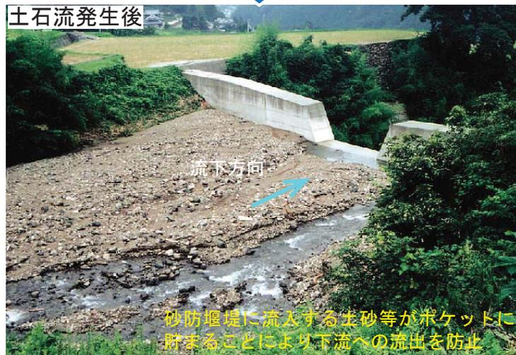
平成11年9月洪水による土砂等を白猪谷砂防堰堤が捕捉し、下流の被害を防止した。
