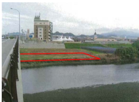
整備前の河口右岸の様子
