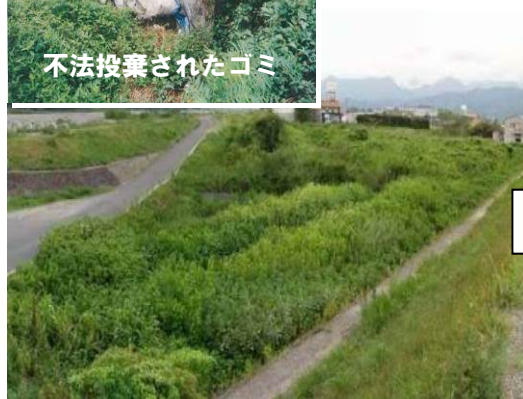
整備前の広瀬霞の様子
