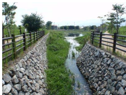
整備された魚道
