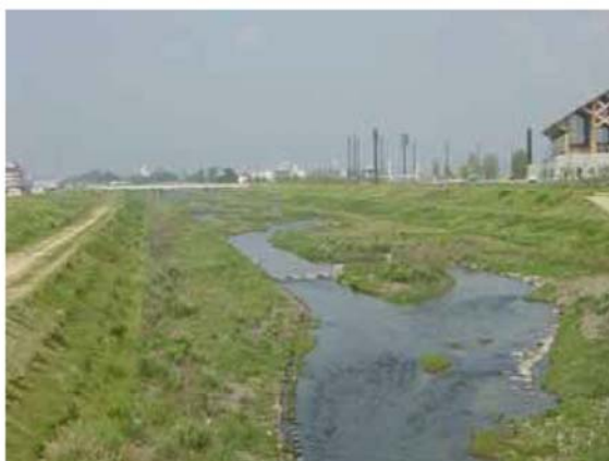
中央公園橋上流
