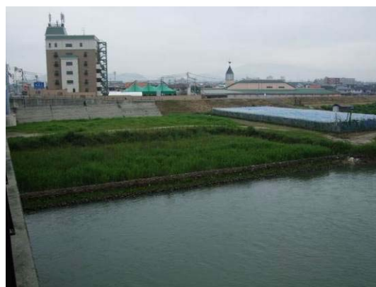
整備後の河口右岸の様子
