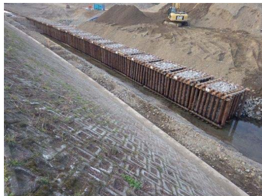
図 2.17 根継ぎ工（松前箇所）
