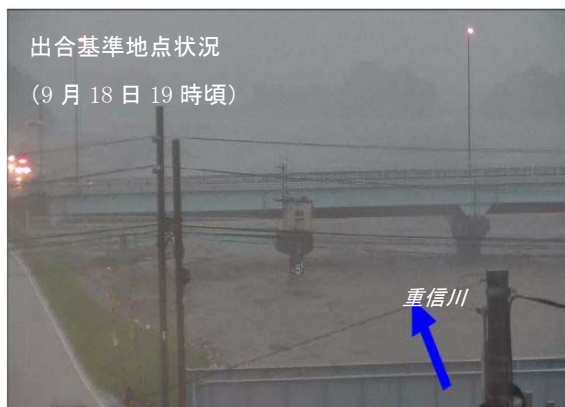
平成 29 年 9 月洪水(出合付近)
