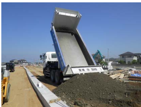
図 4.1 発生土の松山外環状道路への受入状況（平成 28 年度）
