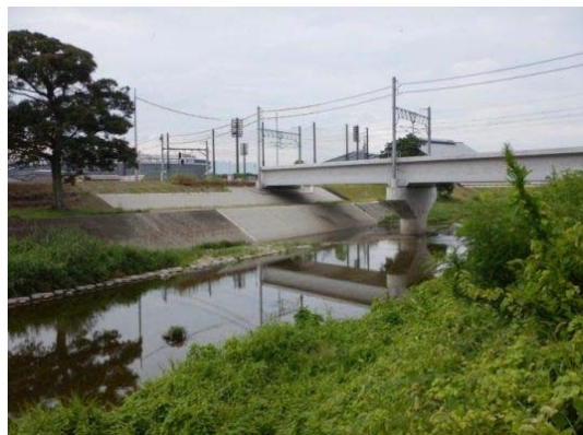
図 2.16 連続立体交差事業（橋梁架け替え完了）
