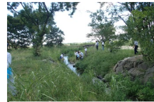
改修水路の状況
