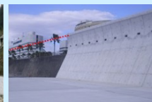
海岸保全施設整備
