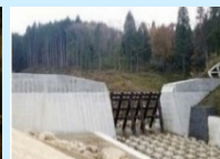
砂防関係施設整備
