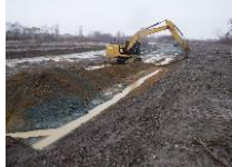
河道掘削 (石狩川水系、北海道開発局)
