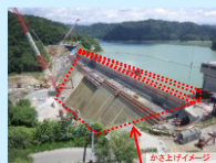
ダム建設・再生
