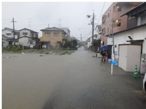
堤内側浸水状況
