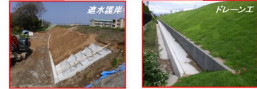
施工状況写真
