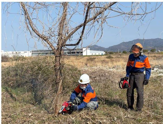
作業写真①
