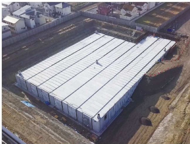
施工事例(貯留容量10,000m 3 )
