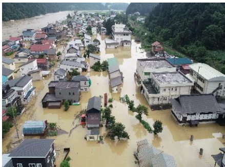
被災状況（古口地区）
