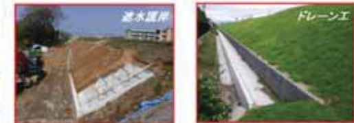
平成30年度工事 施工状況
