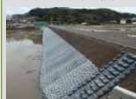
ため池護岸の整備
