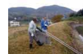
ため池の現地パトロール
