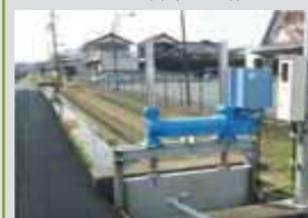
排水門の電動化
