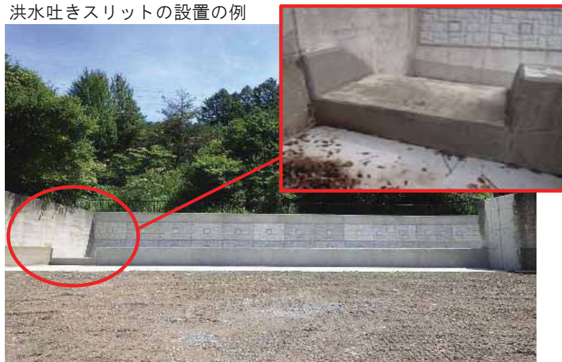
洪水吐きスリットの設置の例
