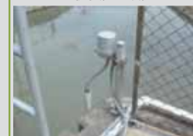
水位計の設置
