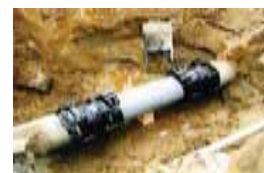
漏水防止のための整備
