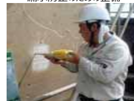
老朽化した施設の機能診断
