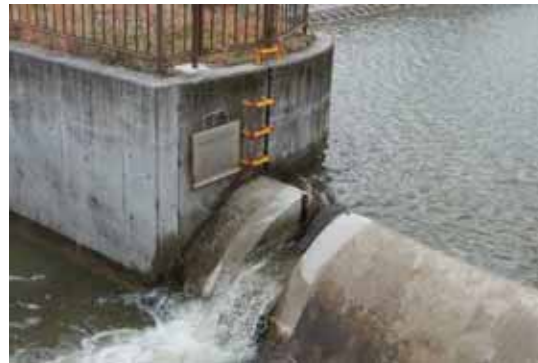
洪水吐きスリットの設置の例
