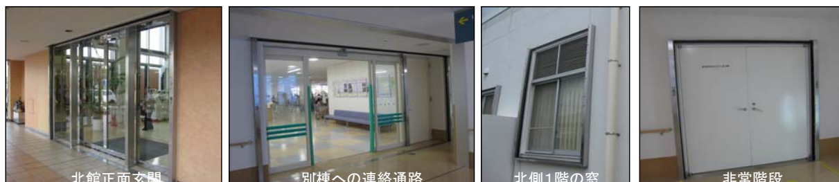
止水板のための角落としの設置
