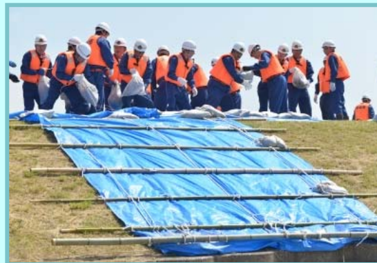
水防団による訓練(シート張工)
