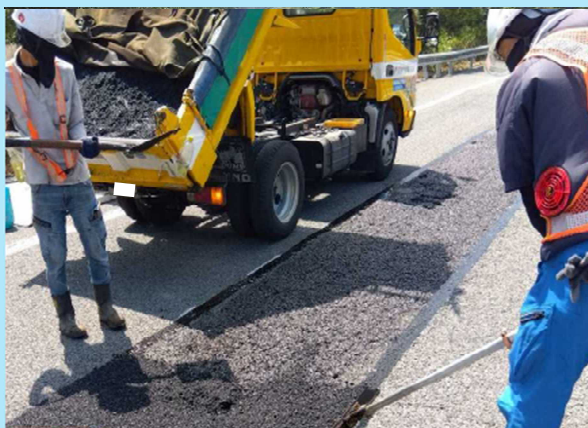
補修工事(舗装)
