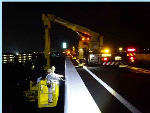
点検作業〈橋梁〉
