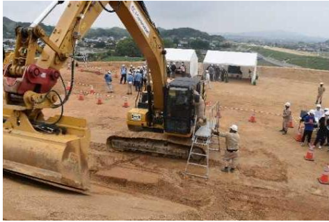
バックホウに設置している GNSS受信アンテナ（2軸）
