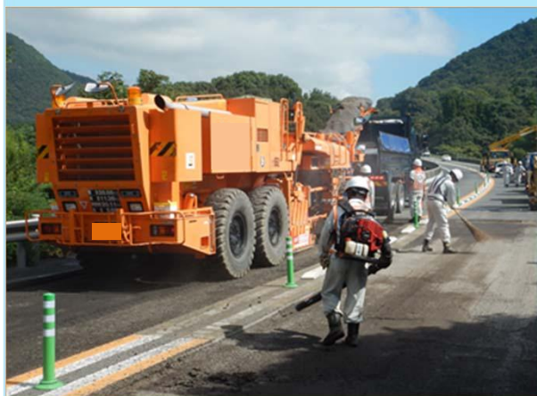
補修工事(舗装)
