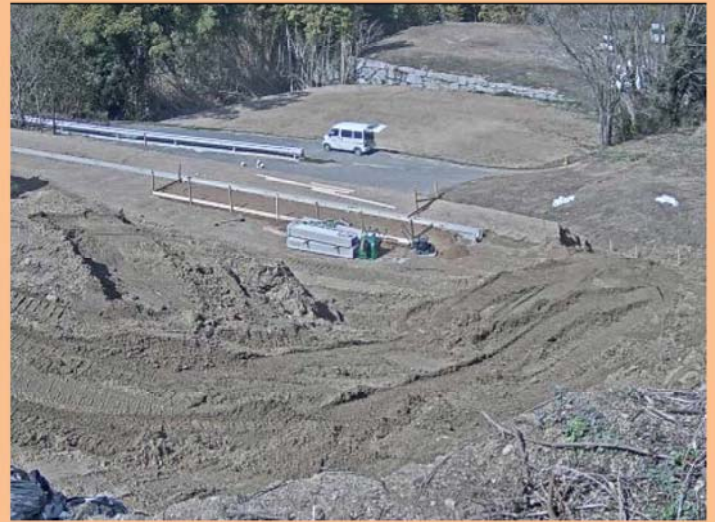
現在の状況(復旧作業中)
