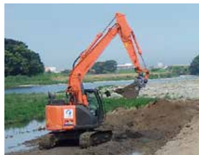
河道掘削（河道維持管理）
