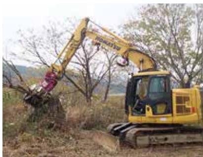
樹木伐採（河道維持管理）
