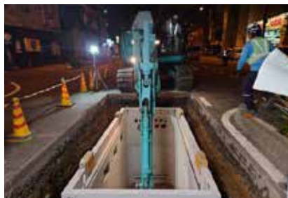
特殊部掘付工事
