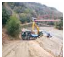
土砂の除去工事の様子
