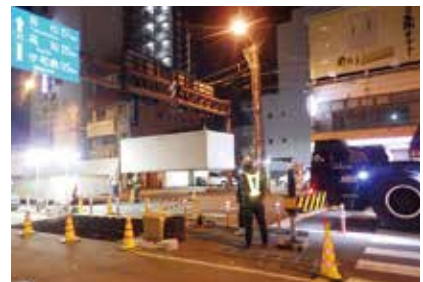
特殊部掘付工事
