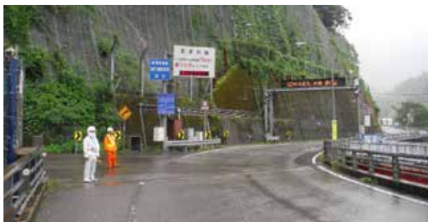
降雨による事前通行規制状況
