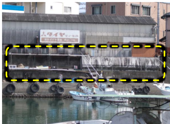
陸閘の統廃合の例（利用頻度の少ない陸閘をコンクリートで閉鎖）
