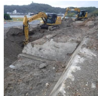
埋設構造物の撤去状況
