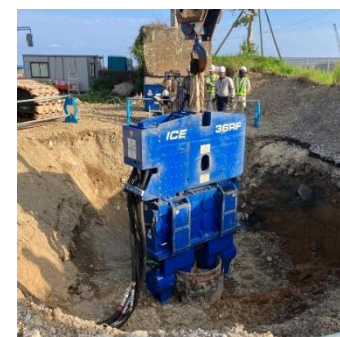
埋設構造物の撤去状況
