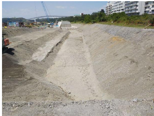
掘削・床掘完了
