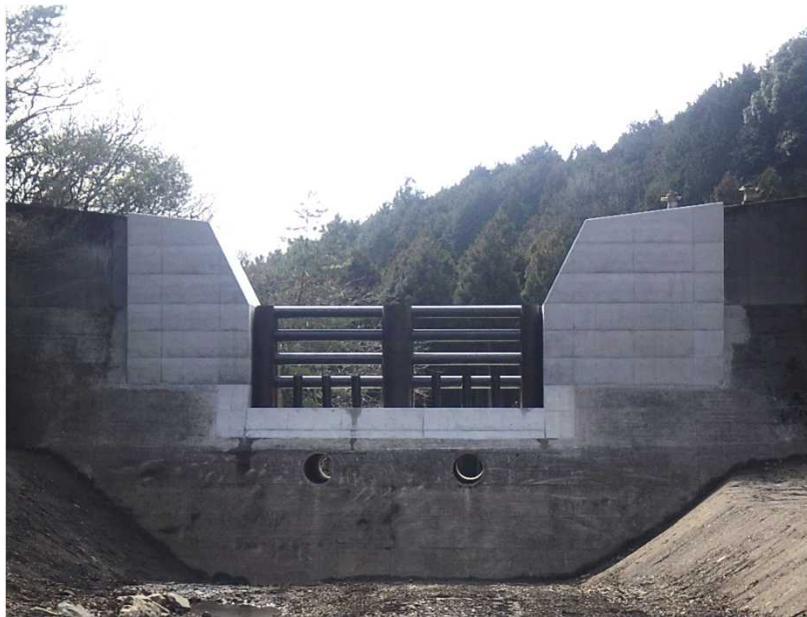
既設堰堤スリット化の事例 (渋谷第二号堰堤)
