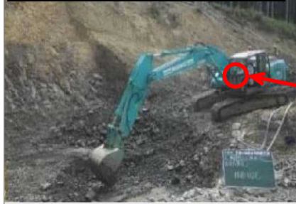
ICT建設機械（MGBH）による施工
