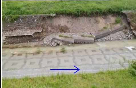
被災状況写真（護岸崩壊）
