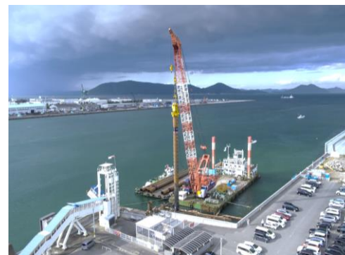
変更計画: 作業船による海上施工
