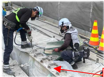
(馬蹄形ジベル内コンクリートの手斫り作業)
