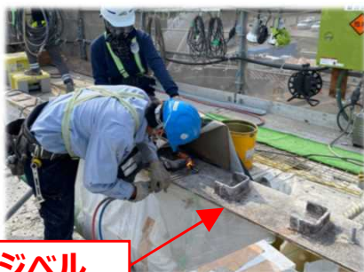
(馬蹄形ジベルのガス切断作業)
