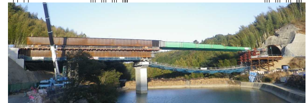
▲手延べ式送り出し架設のイメージ
