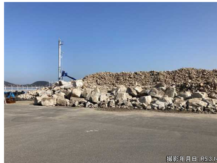
石材の仮置状況
