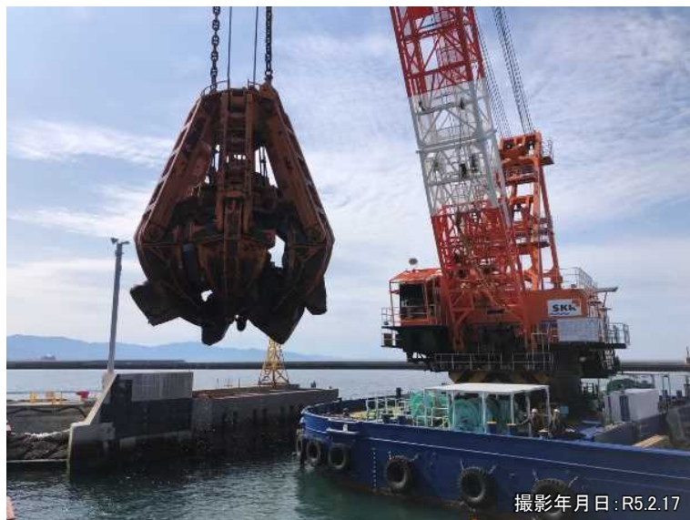
石材の撤去状況
