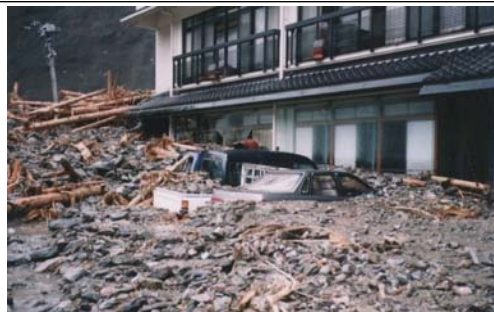
④とびのす谷出口付近のホテル被災状況(平成11年)
