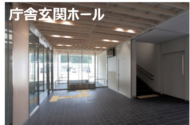
木材利用促進：庁舎玄関ホール内装木質化
