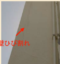
外壁：外壁にひび割れが発生
