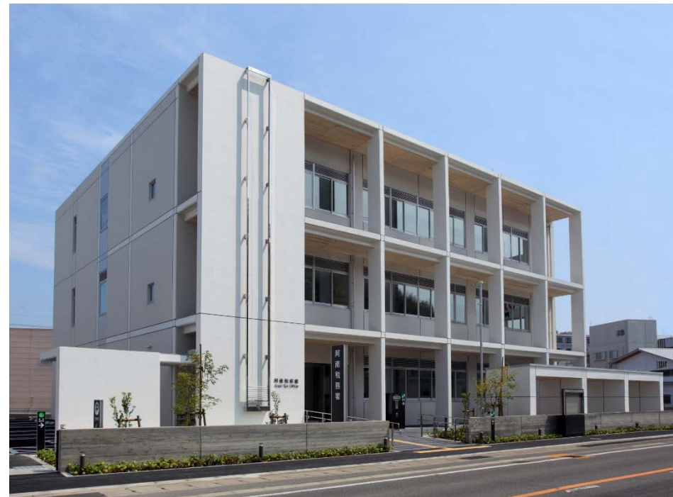
①庁舎南西面 平成31年4月完成
