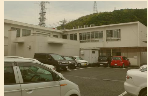
②旧庁舎北西面 4
