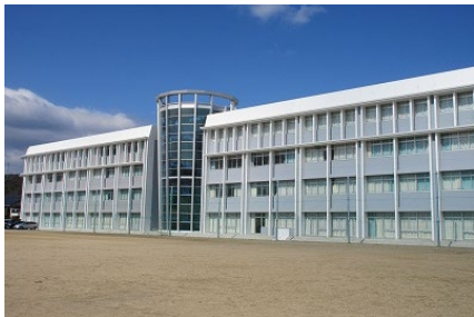
完成した新校舎
