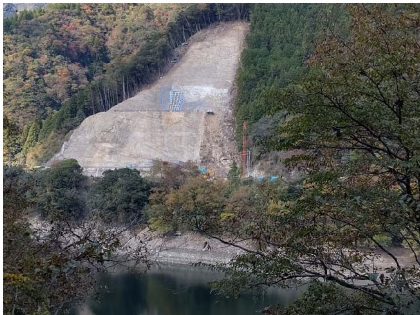
写真-12-1 山腹工の施工状況
