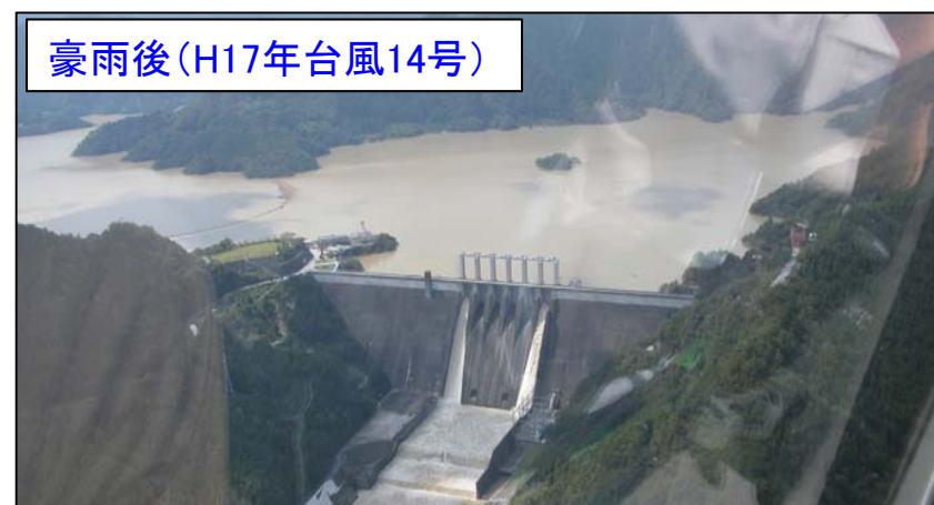
写真-2-3 早明浦ダムの濁水発生状況
