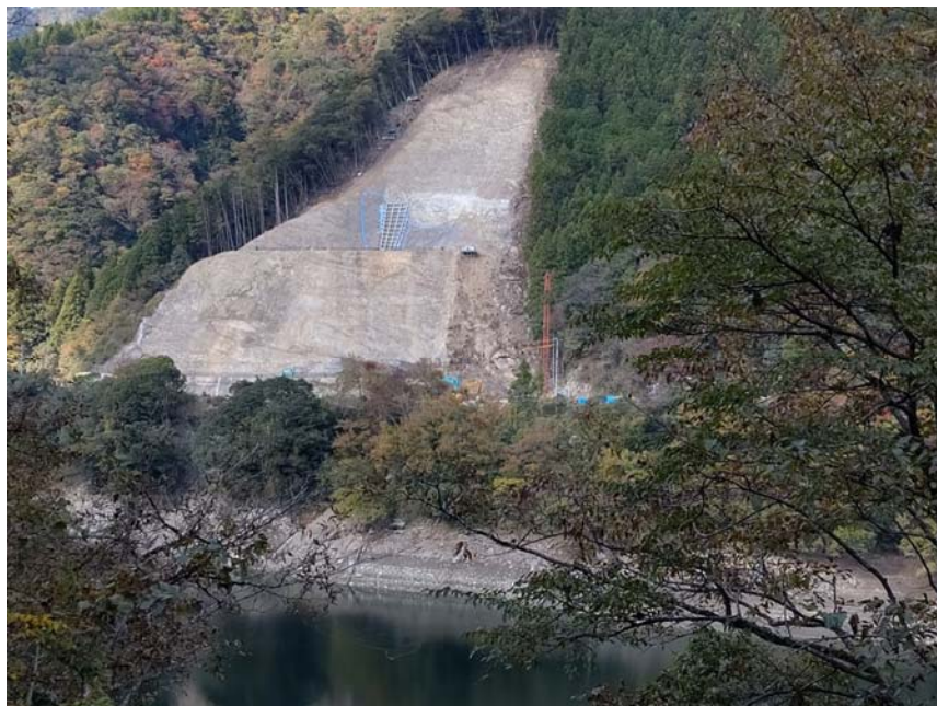
写真-12-1 山腹工の施工状況
