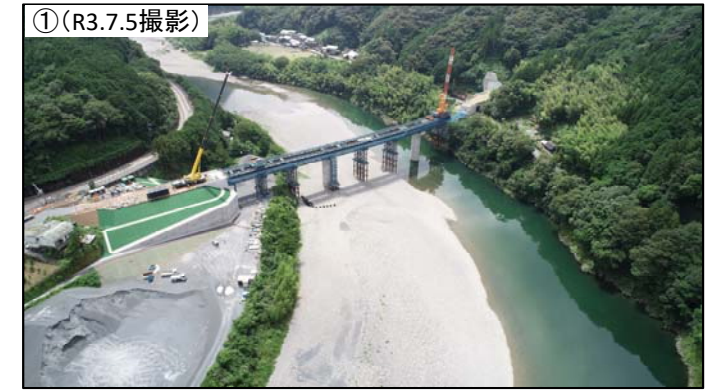
①(R3.7.5撮影) ▲新横倉橋上部工施工状況
