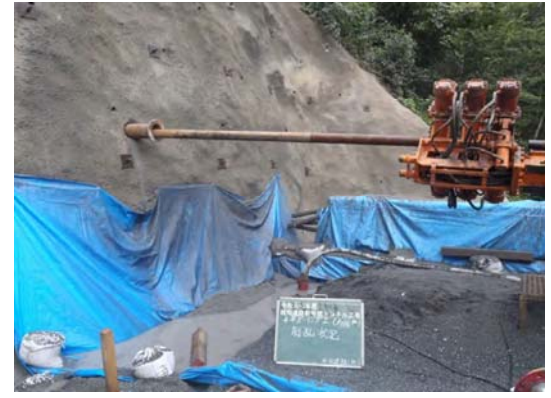
先進ボーリング (ダウンザホールハンマ工削孔状況)
