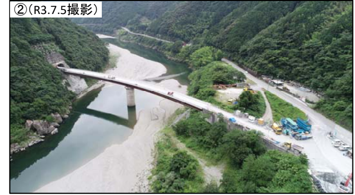
②(R3.7.5撮影) ▲立花大橋上部工施工完了
