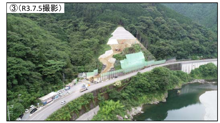
③(R3.7.5撮影) ▲現道改良施工状況
