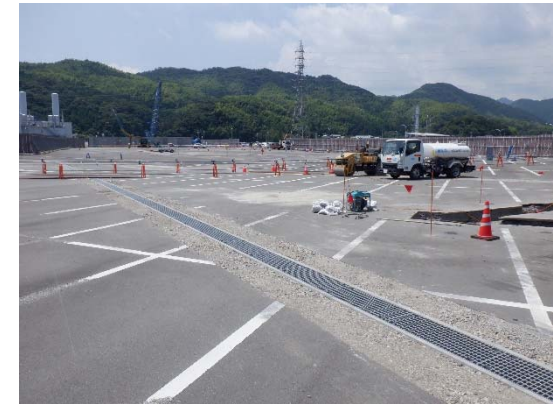
【写真② 下大野地区(下大野高架橋)】
