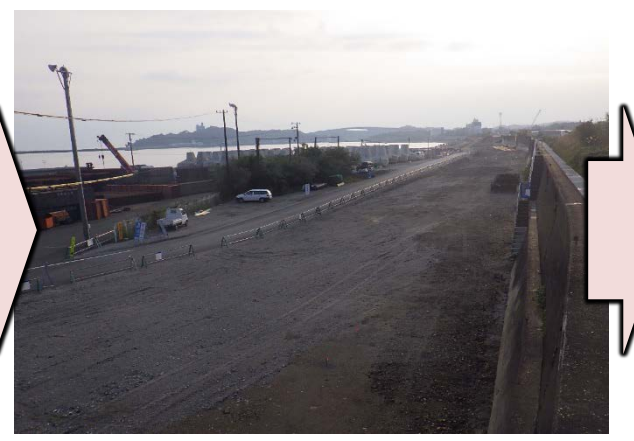
掘削・床掘前
