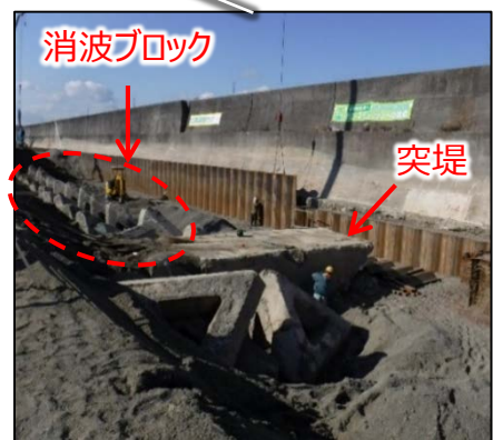
③埋設物の状況
