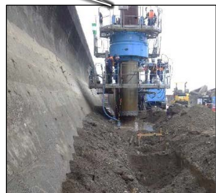
地中埋設物 (先行掘削による対応)
