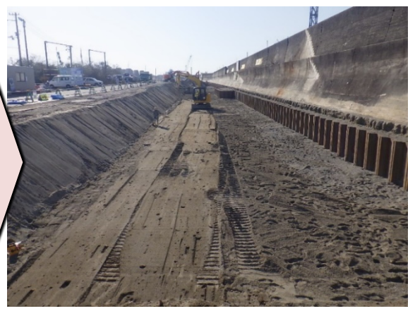
掘削・床掘完了
