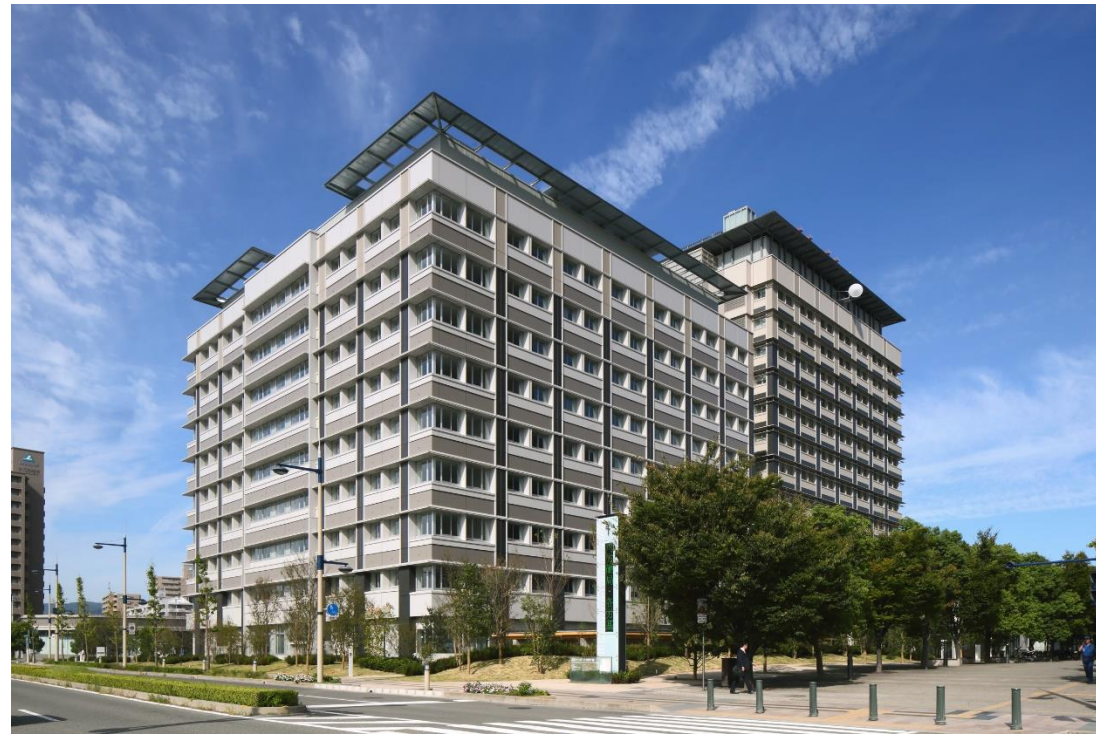
高松地方合同庁舎 完成写真（手前がⅡ期・南館）
