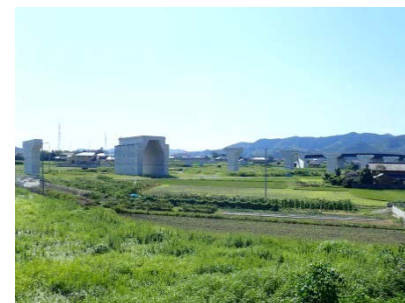
【写真④ 前原地区(江田高架橋)】 ※撮影日: 令和元年9月
