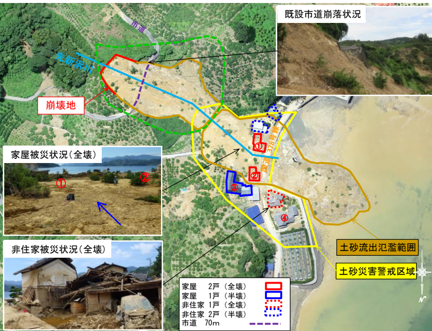
○平成30年7月豪雨による土石流災害（愛媛県宇和島市）
