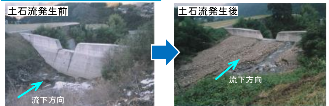
平成10年3月に完成し、平成11年9月の土石流を捕捉し下流の被害を軽減
