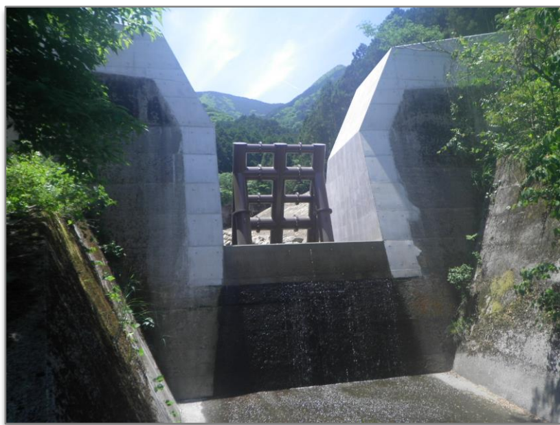
既設堰堤スリット化の事例 こうちだにかいだん (高智谷階段第2号堰堤) H29.6完成
