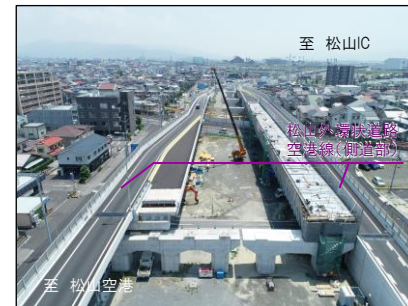
【写真③】 余戸南跨線橋付近
