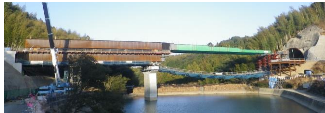
▲手延べ式送り出し架設のイメージ
