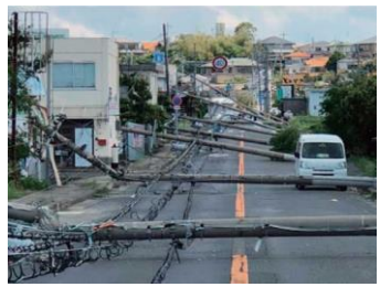
大阪府泉南市の被災状況 (平成30年台風21号)
