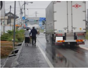
歩道未整備区間
