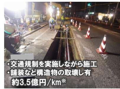
<交通規制を実施しながらの施工状況> ※一般的な整備費用(第1回 無電柱化あり方検討委員会より引用)
