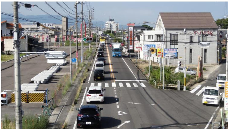
拡幅事業区間の状況(本山小学校前交差点付近) 撮影日:平成30年8月
