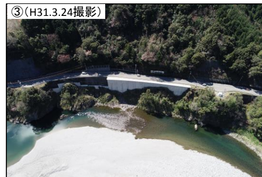
▲現道改良施工状況
