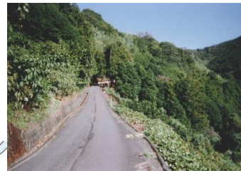
▲幅員の狭い迂回路
