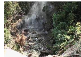
▲不安定岩塊を発破により除去
