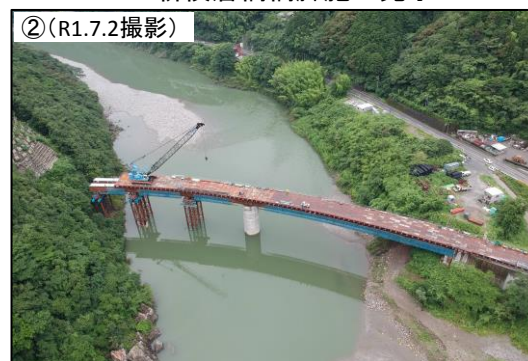
▲立花大橋上部工施工状況
