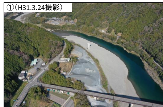
▲新横倉橋橋脚施工完了
