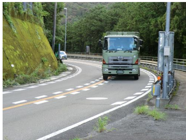
写真① 平面線形不良区間
