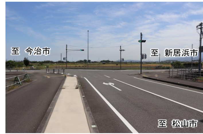
【写真②】小松バイパス開通区間から起点部方面を臨む
