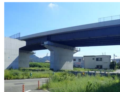
【写真③ 前原地区(C1ランプ橋)】
