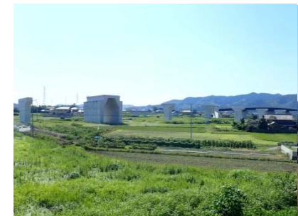
【写真④ 前原地区(江田高架橋)】
