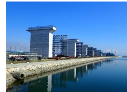
【写真② 沖洲地区(沖洲高架橋)】
