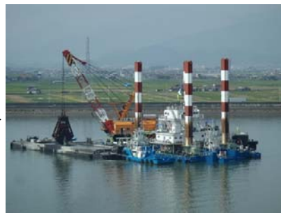
グラブ浚渫船(東予港)
