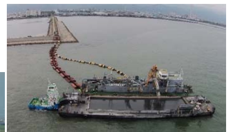
バージアンローダー揚土船(東予港)
