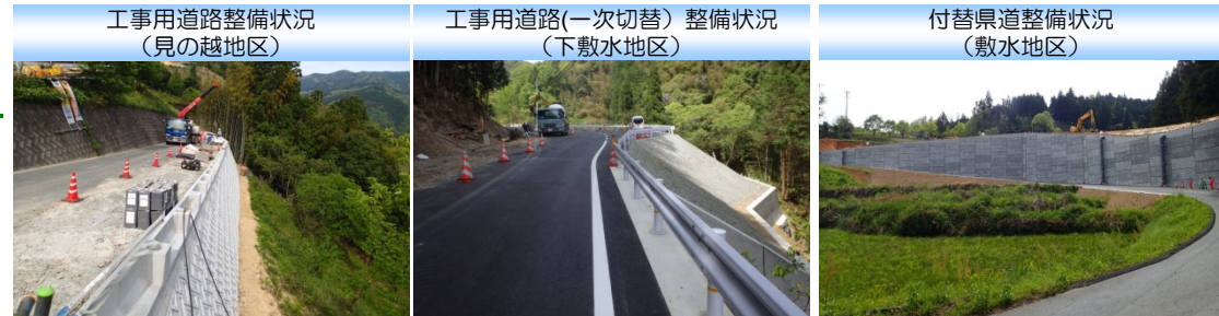
工事実施状況 (H27.3月末時点)
