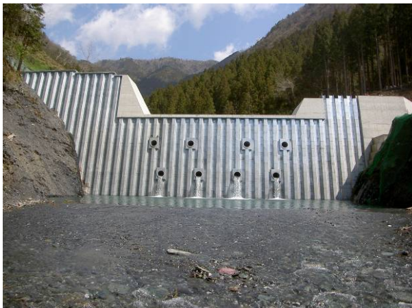
写真 21 ダブルウォール工法
