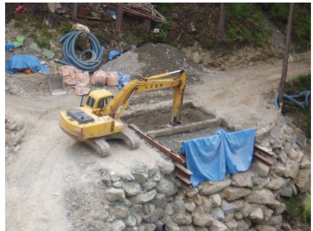
写真 22 砂防ソイルセメント (INSEM) 工法
