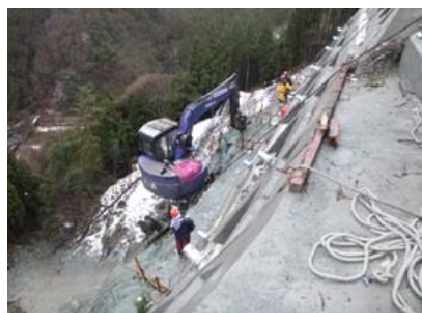
写真6 カシケ谷堰堤
