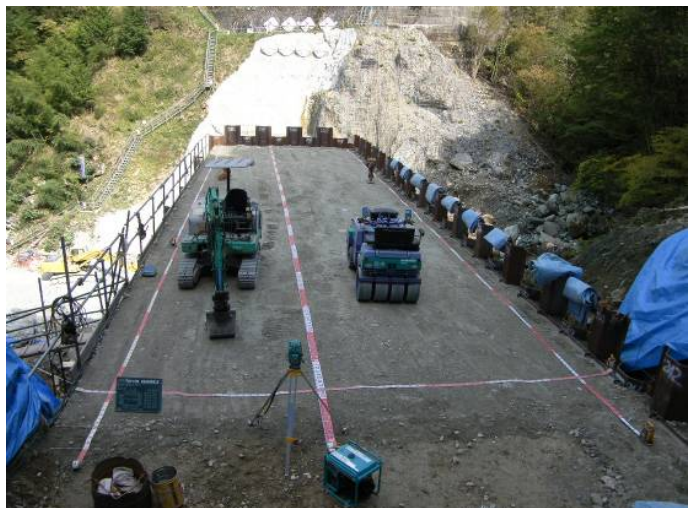
写真 23 砂防ソイルセメント施工状況
