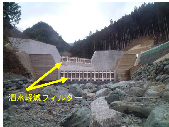
写真 27 濁水対策に配慮した長又第2堰堤 （早明浦ダム上流）
