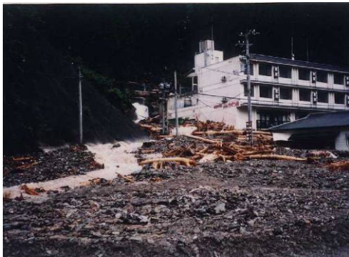
写真8 平成11年の土石流被害状況
