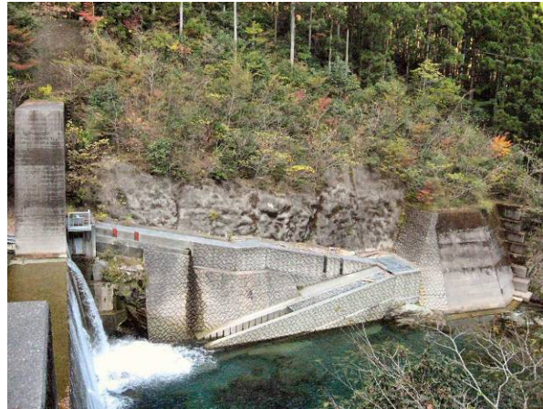
写真 29 魚道を整備した汗見川堰堤（汗見川）
