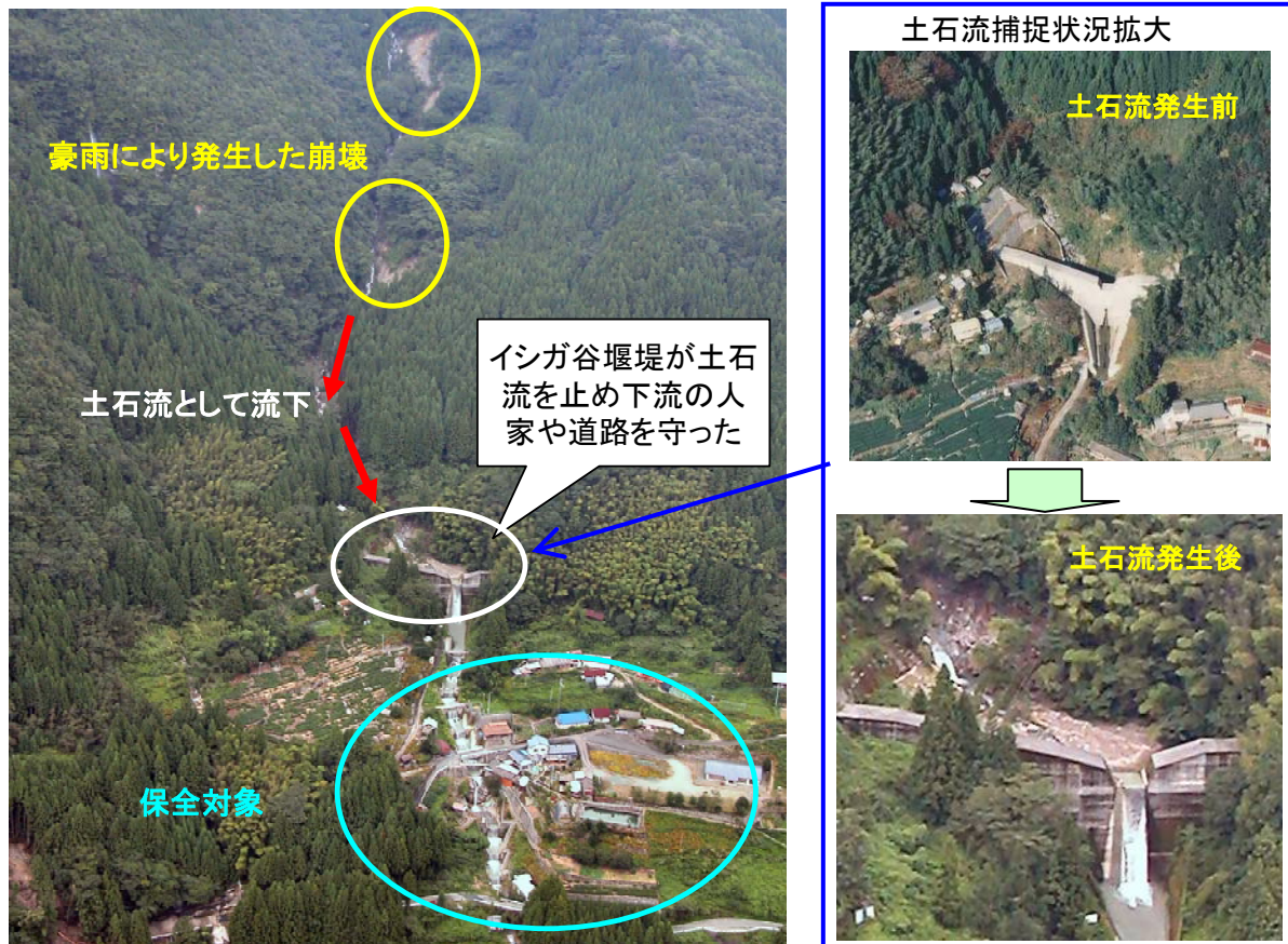
写真20 イシガ谷堰堤（土佐町）
