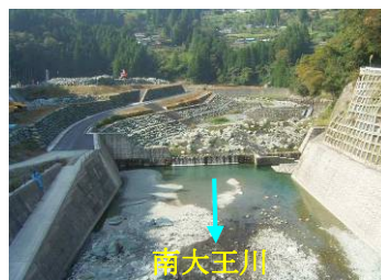
写真4 落合床固工群
