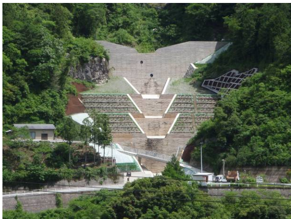
写真 28 間伐材を使用した水谷堰堤 （早明浦ダム上流）
