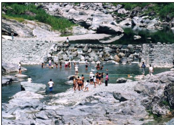
写真 24 善徳床固工（祖谷川）
